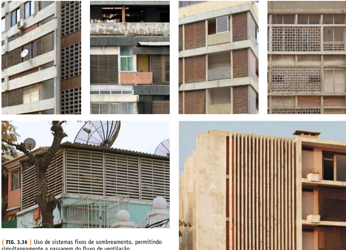
{ FIG. 3.36 } Uso de sistemas fixos de sombreamento, permitindo simultaneamente a passagem do fluxo de ventilação.
