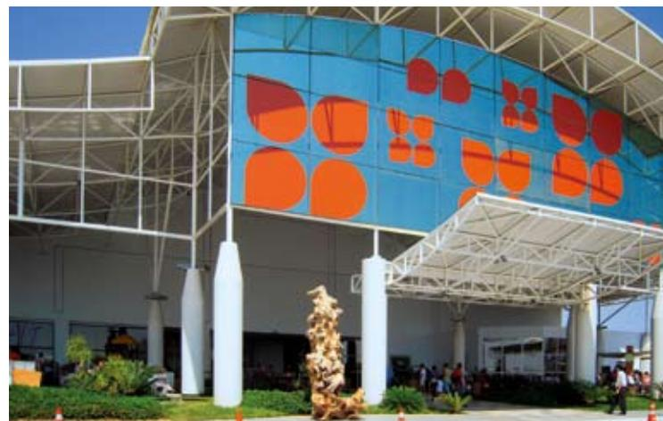
{ FIG. 3.20 } Sombreamento fixo: arcadas (esquerda, em baixo); projecção da cobertura (esquerda, em cima); e palas fixas num edifício comercial contemporâneo (direita).
