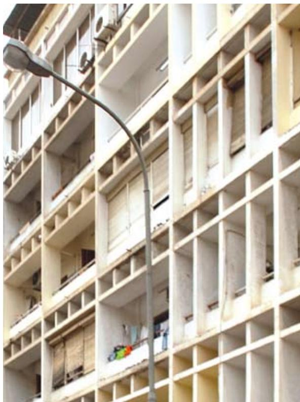
{ FIG. 3.16 } Utilização de palas fixas verticais e horizontais de sombreamento, num edifício modernista em Luanda.
